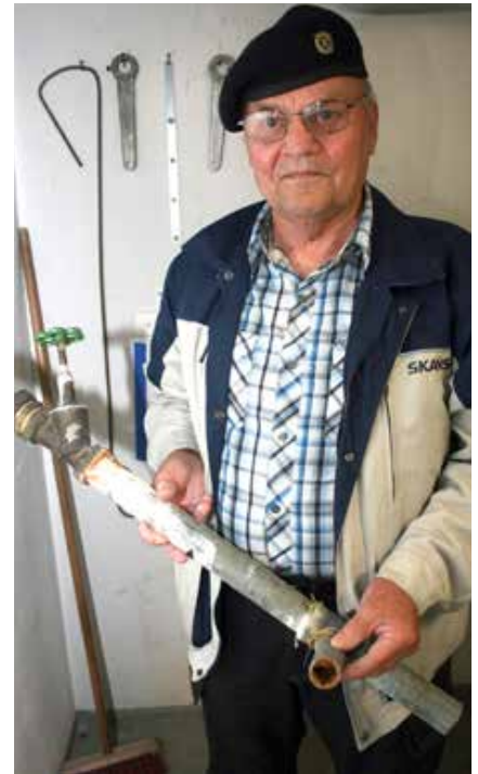
Markku Brander esittelee putkea, joka poistettiin ennen Bauer-vedenkäsittelylaitteiden asennusta ongelman havainnollistamisen vuoksi. Putkeen on kertynyt sakkaa, mikä tukkii putkea. Päällisin puolin putki näyttää olevan kunnossa.
