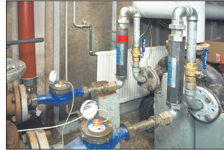
Bauer-vedenkäsittelylaitteet asennettuina vesimittareiden jälkeen.
