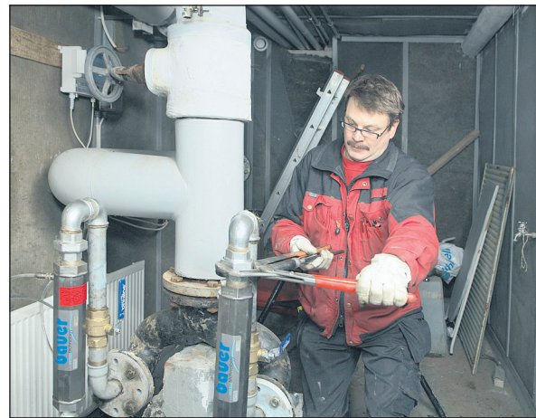
Bauer-vedenkäsittelylaitteet asennettuina vesimittareiden jälkeen.
