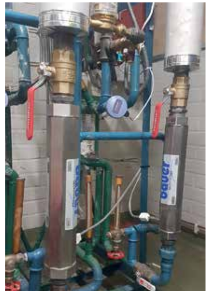
Kuhmon virastotalossa ja Teletalossa Bauer-vedenkäsittely on asennettu sekä lämmitys- että ilmanvaihtojärjestelmään. Tasainen lämmönjako, energiankäytön tehostuminen ja säästöt ylläpitokuluissa ovat olleet merkittäviä hyötyjä.
