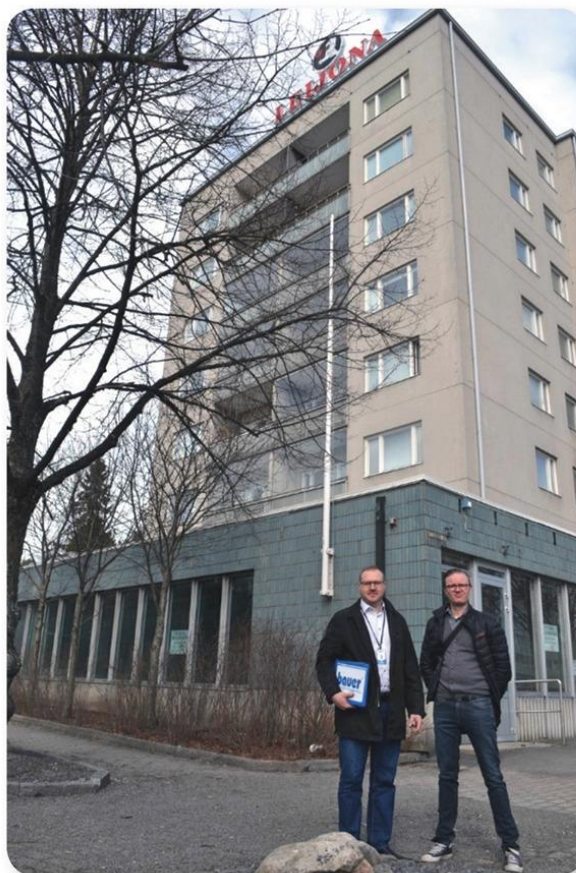
Asunto-osakeyhtiö Tuirantornissa Oulun Merikoskenkadulla Bauerin vedenkäsittelylaite on tuonut avun lämpöpatteriverkoston saostumaongelmiin, kertovat Sami Niemi (vas.) ja isännöitsijä Mika Nieminen.
